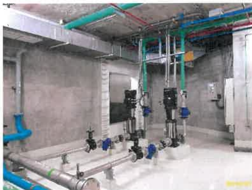
ปั๊ม และถังสำรองเพื่อการอุปโภค-บริโภคชั้น 26M
