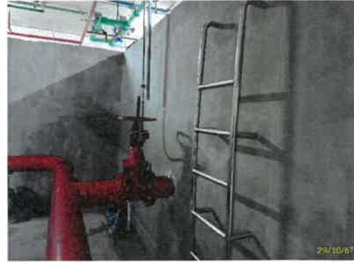
ปั๊ม และถังสำรองเพื่อการอุปโภค-บริโภคชั้น 42M
